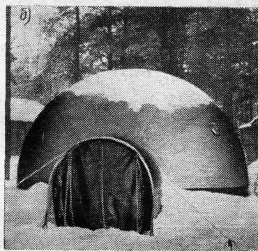
Рис. 5.15. Мягкое заполнение проема людского шлюза а — в открытом виде; б — в закрытом виде
