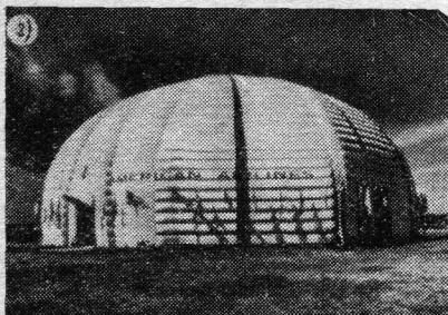
Рис. 1.16. Воздухонесомые (пневмопанельные) конструкции
